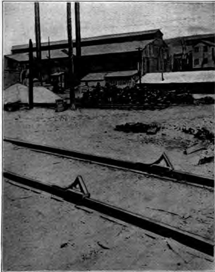
FIG. 8.—“SABOT FRIEN” BRAKE SKID.
